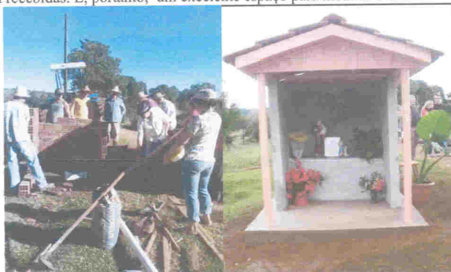
(Capitel construído em abril de 2011, em sistema de mutirão pela Associação.)
