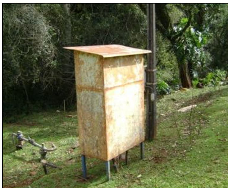
Figura 25 – Poço 13 Linha Liso Fonte: Acervo Espaço Urbano
