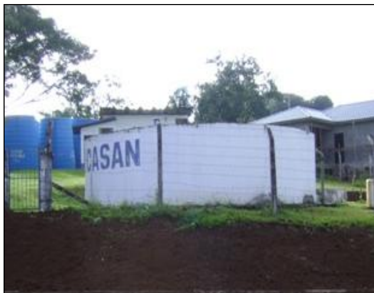
Figura 27- Reservatório R-1 (Rua 13 de Outubro). Fonte: Acervo Espaço Urbano
