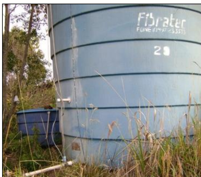
Figura 28 - Reservatório R-4 (Rua São Cristóvão). Fonte: Acervo Espaço Urbano
