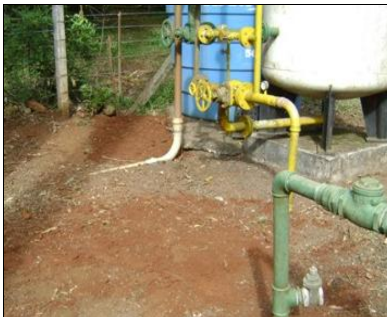
Figura 24 – Poço 12 Linha Liso Fonte: Acervo Espaço Urbano
