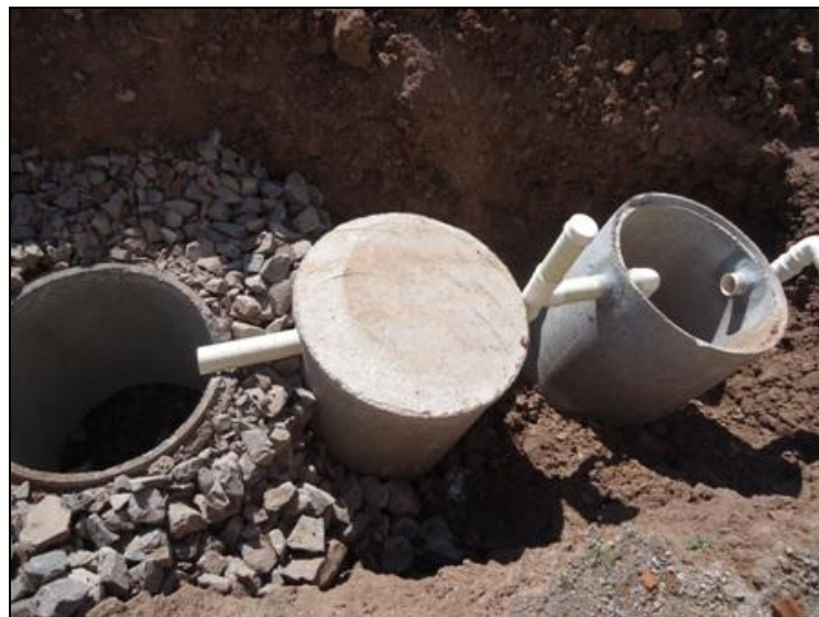
Figura 53 - Sistema de Fossa, Filtro e Sumidouro utilizado nas residências de Guaraciaba Fonte: Acervo Espaço Urbano
